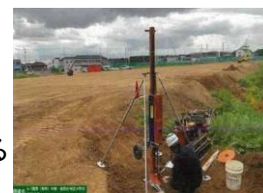
【杭工事の様子】
